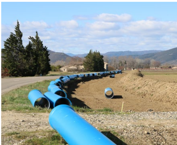
Certaines portions techniques du tracé, comme le passage dans le microtunnelier sous l'autoroute A7 et la voie SNCF ainsi que le passage en baïonnette de la rivière Véore, ont nécessité la fourniture du système de verrouillage double chambre ELECTROLOCK®.
