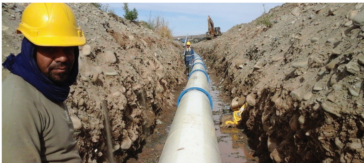
Canalisations fonte DN 600 verrouillée ELECTROLOCK® Polyuréthane PUX®
