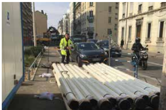
Revêtement extérieur en polyuréthane conforme à la norme EN 15 189
